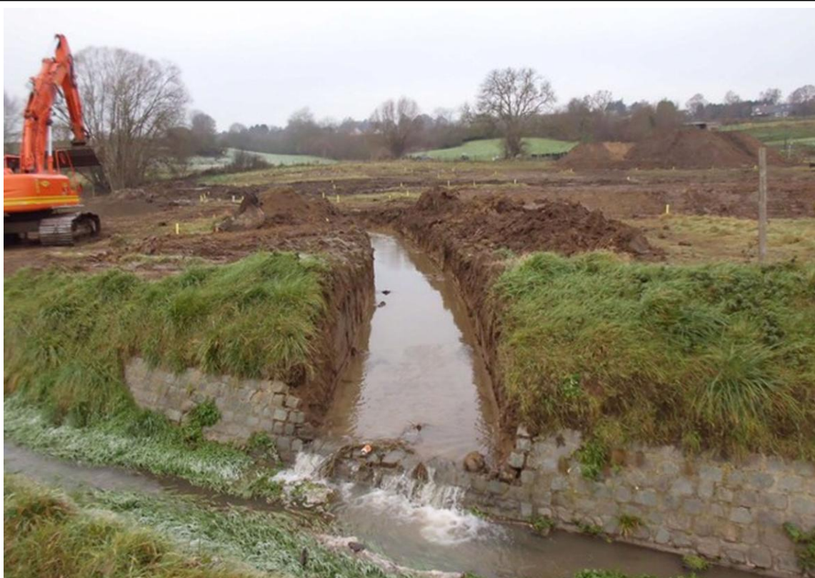
Figuur 34 Werken aan het wachtbekken in 't Helleke
